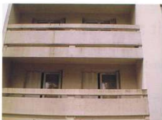
Garde-corps en béton
