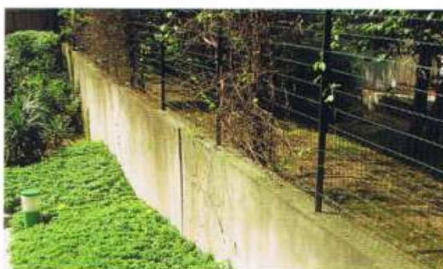
Mur de soutènement
