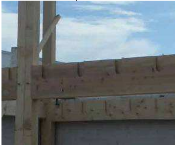
Détail montrant les mortaises dans lesquelles vont venir s'emboîter les tenons des poutres transversales.
