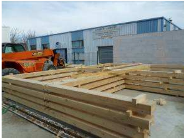
Stockage sur le chantier des fermes assemblées en atelier
