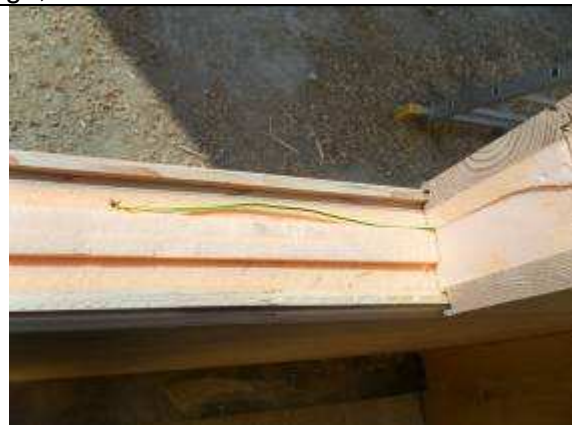
Madriers sandwichs des murs de façades.
